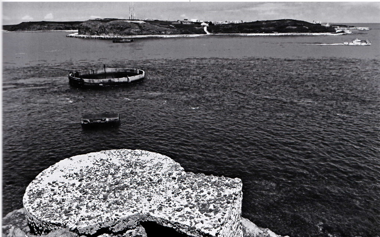
花費二億元卻沉入海底的澎湖望將大橋橋墩。
